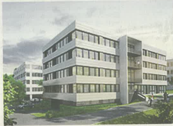
Visualisierung Businesshaus II Göppingen – im Bau befindlich.
