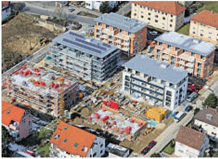
Bebauung ehemaliges Firmenareal der Fa. Edelmann „Wohnen in der Stadt“ – Paradiesstraße / Heinrich-Heine-Straße, Heidenheim
