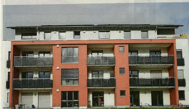
Die Bauarbeiten des ersten Bauabschnitts in Nattheims Mitte sind abgeschlossen.
